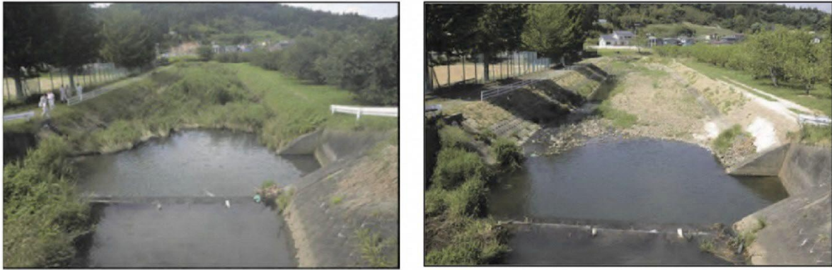
図 3.12 上小国川における除染実施前（左）および除染実施後（右）の河床（提供：福島県－「前プロジェクトの最終報告書」掲載）
