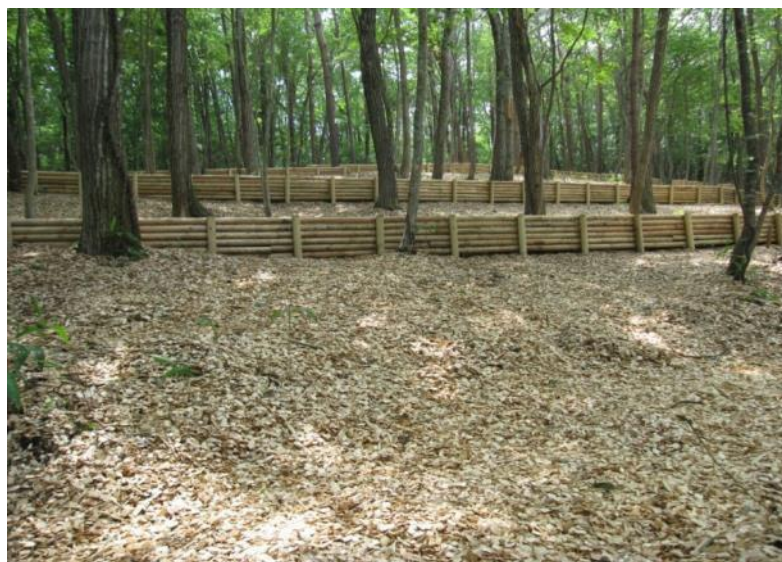
図 2.5 森林の空間線量率の低減対策としての木材チップの敷設（提供：福島県）
